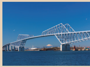
東京ゲートブリッジ
